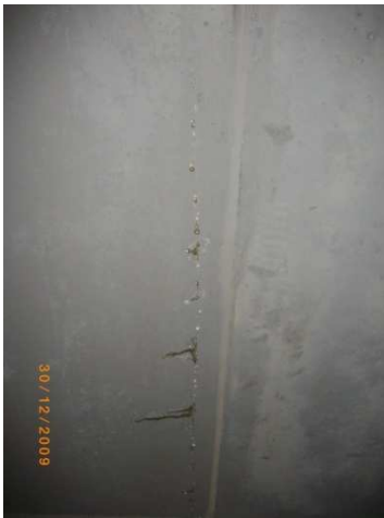
Infiltrações numa fissura no tecto.
