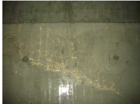
Nesta situação todo o material que não estava bem aderido ao suporte foi removido com a decapagem.
