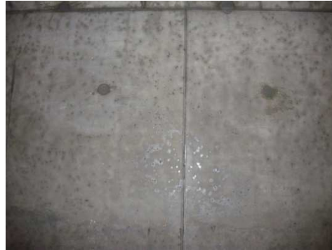
É possível verificar a abertura dos poros após a decapagem do suporte.
