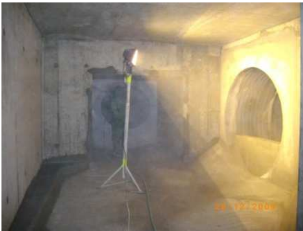
Entrada de água vinda exterior no início do caneiro.
