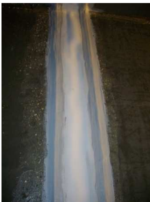
Grandes níveis de humidade perto das juntas.
