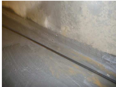
Infiltração num pequeno furo na parede.
