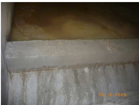
Acumulação e passagem de água a meio do caneiro.
