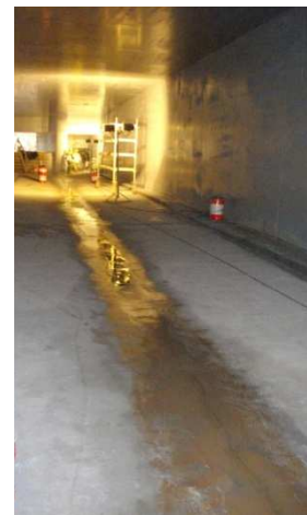
Passagem constante de água no pavimento ao longo do caneiro.
