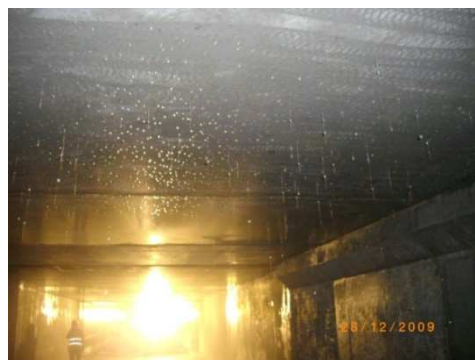
Nesta situação todo o material que não estava bem aderido ao suporte foi removido com a decapagem.
