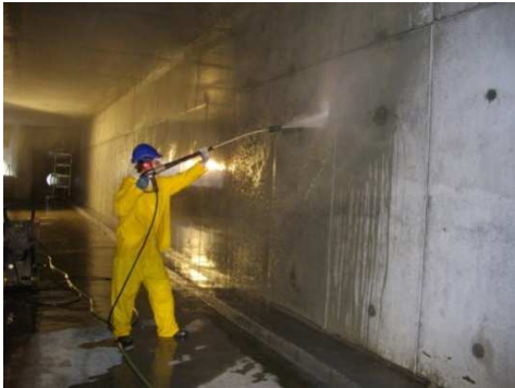
Decapagem da parede a alta pressão.
