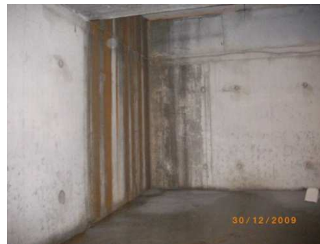
Passagem constante de água no pavimento ao longo do caneiro.
